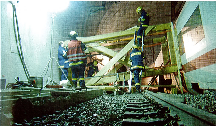
Abstützen des ICE Waggons im Landrücken-Tunnel bei Fulda
