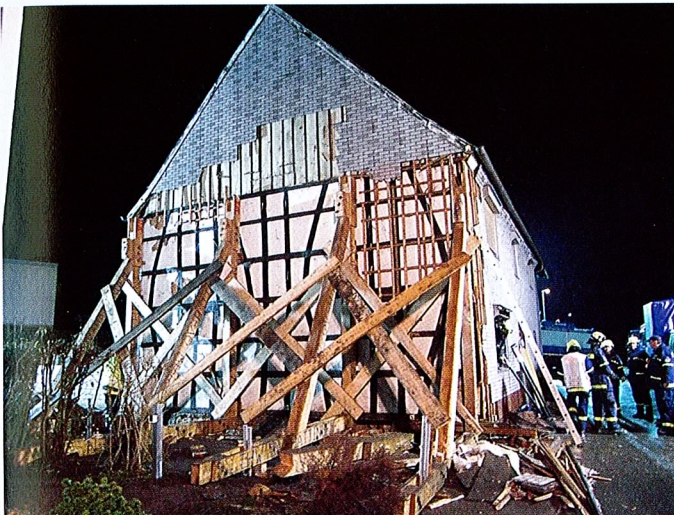
Giebelabstützung mit dem Abstützsystem Holz in Sprockhövel
