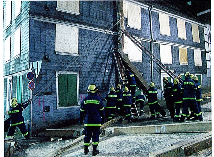
Errichten einer Korsage mit Kantholz und Ankerstäben in Wuppertal
